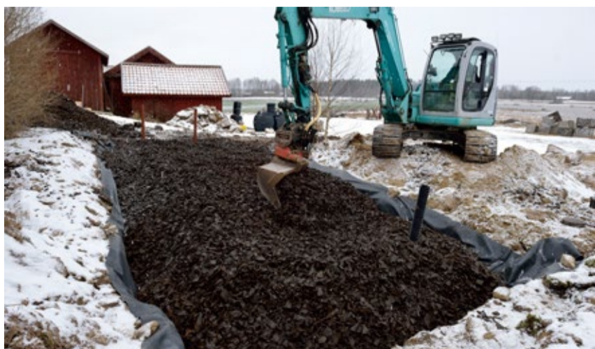
Anläggning av en markbädd med gummigrus, som ersättningsmaterial till naturgrus, för ett enskilt avlopp i Örebro kommun.
